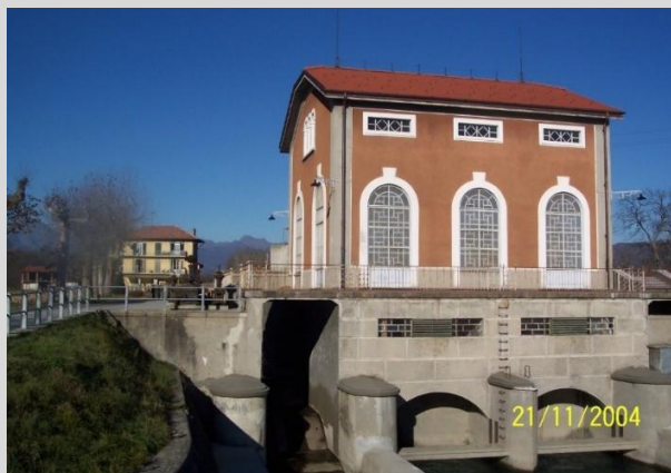
Centrale elettrica SIPEA
