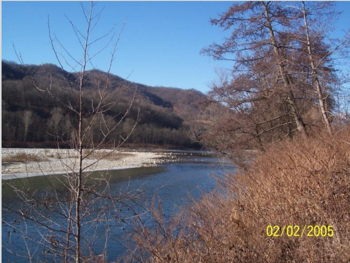
Briglia di presa della Mora al Sasso del Bagno
