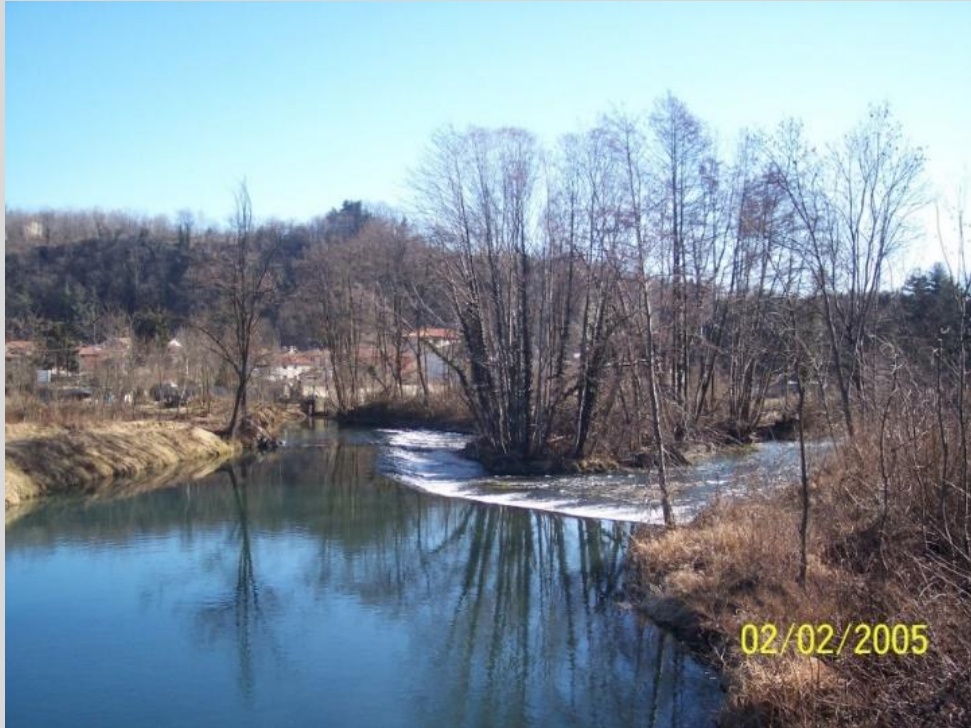
Sfioratore e diramazione per la roggia del mulino di Prato
