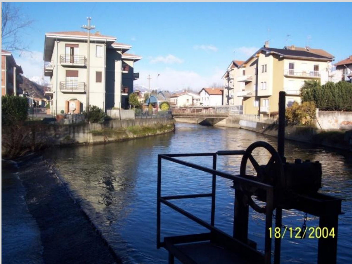
A sinistra lo scaricatore prima dell'Incastrone di Romagnano
