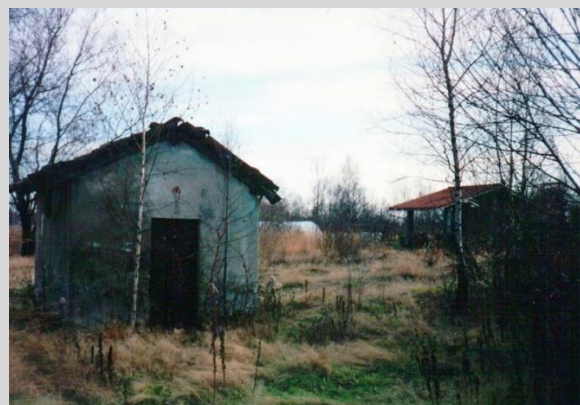
Baraggia – oltre la pineta verso Romagnano
