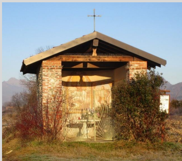
Cappella di San Marco restaurata
